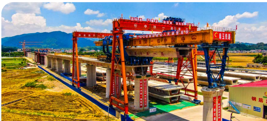
本行支持的新建南宁至玉林铁路项目 Construction of Nanning-Yulin Railway Supported by CDB
