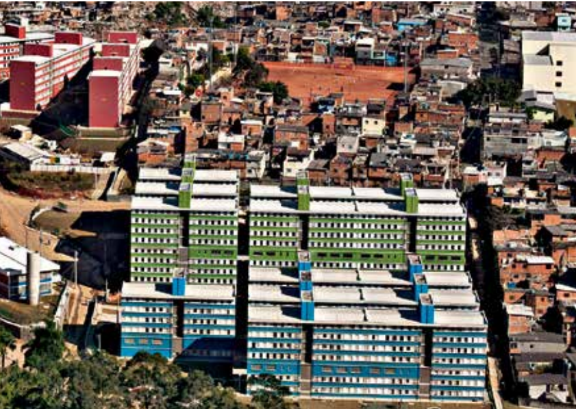
Integrante do PAC, o Complexo Paraisópolis (SP) é uma referência em construção sustentável, tendo obtido o selo Casa Azul CAIXA nível ouro
