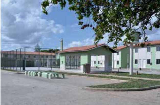
Como parte de suas responsabilidades na área habitacional, a CAIXA desenvolve iniciativas voltadas à execução de construções sustentáveis
