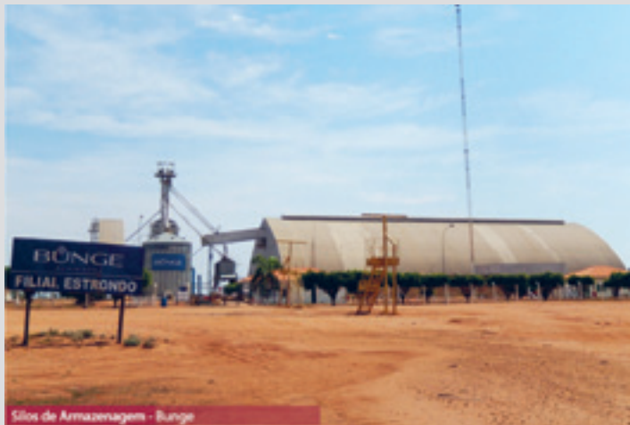
Silos de Armazenagem - Bunge
