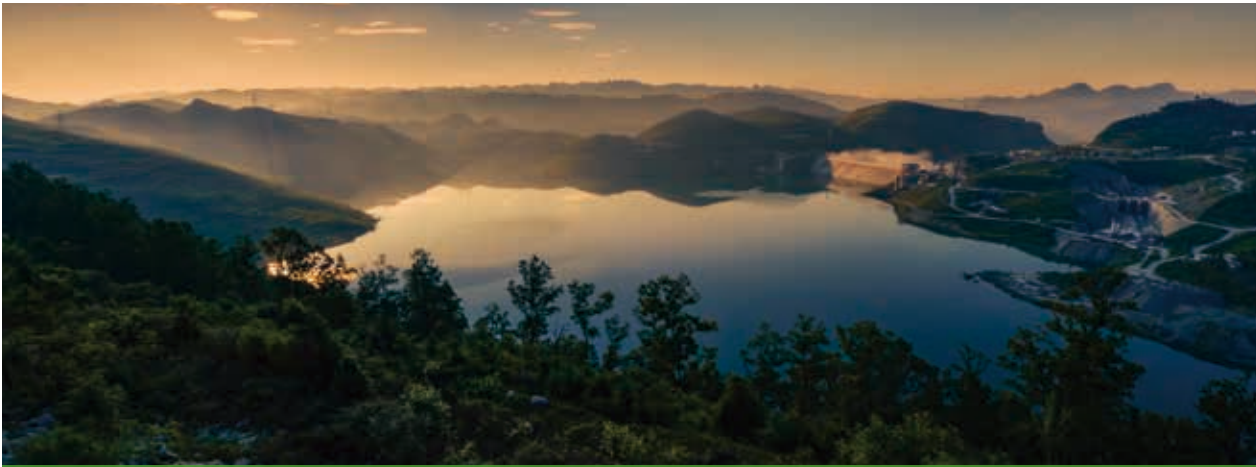
建设银行贵州分行大力支持黔中水利枢纽工程，图为黔中水利枢纽一期工程中的平寨水库
