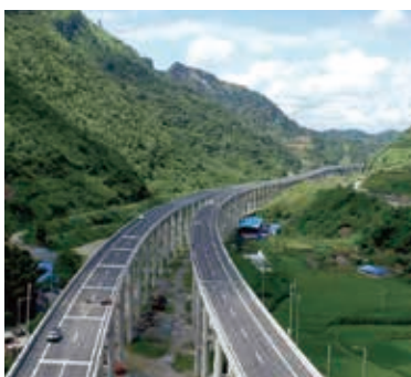
建设银行支持建设的惠罗高速公路
