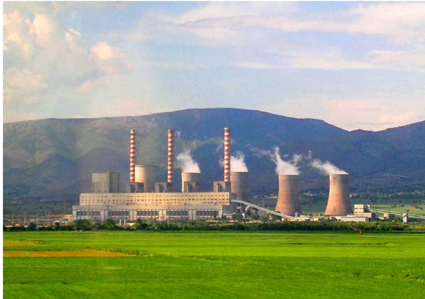
Die bestehenden Kohlekraftwerke Ptolemaida I-IV sollen um einen weiteren Block Ptolemaida V (660MW) erweitert werden. Die KfW IPEX-Bank ist momentan noch der einzige Investor für den Neubau, Bild: PattyK.
