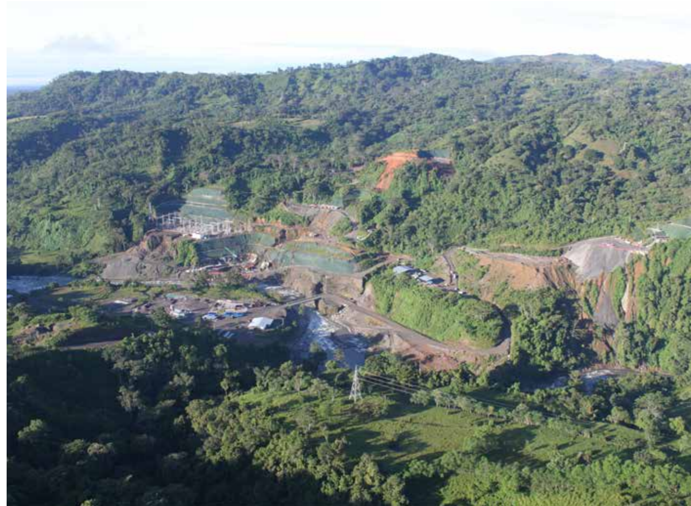
Bauarbeiten zu Pando-Monte Lirio im Oktober 2010 Bild: Alianza Ambiental Pro Desarrollo Integral Unidos por Panamá (AAPRODIUPA) Y FUNDICCEP
