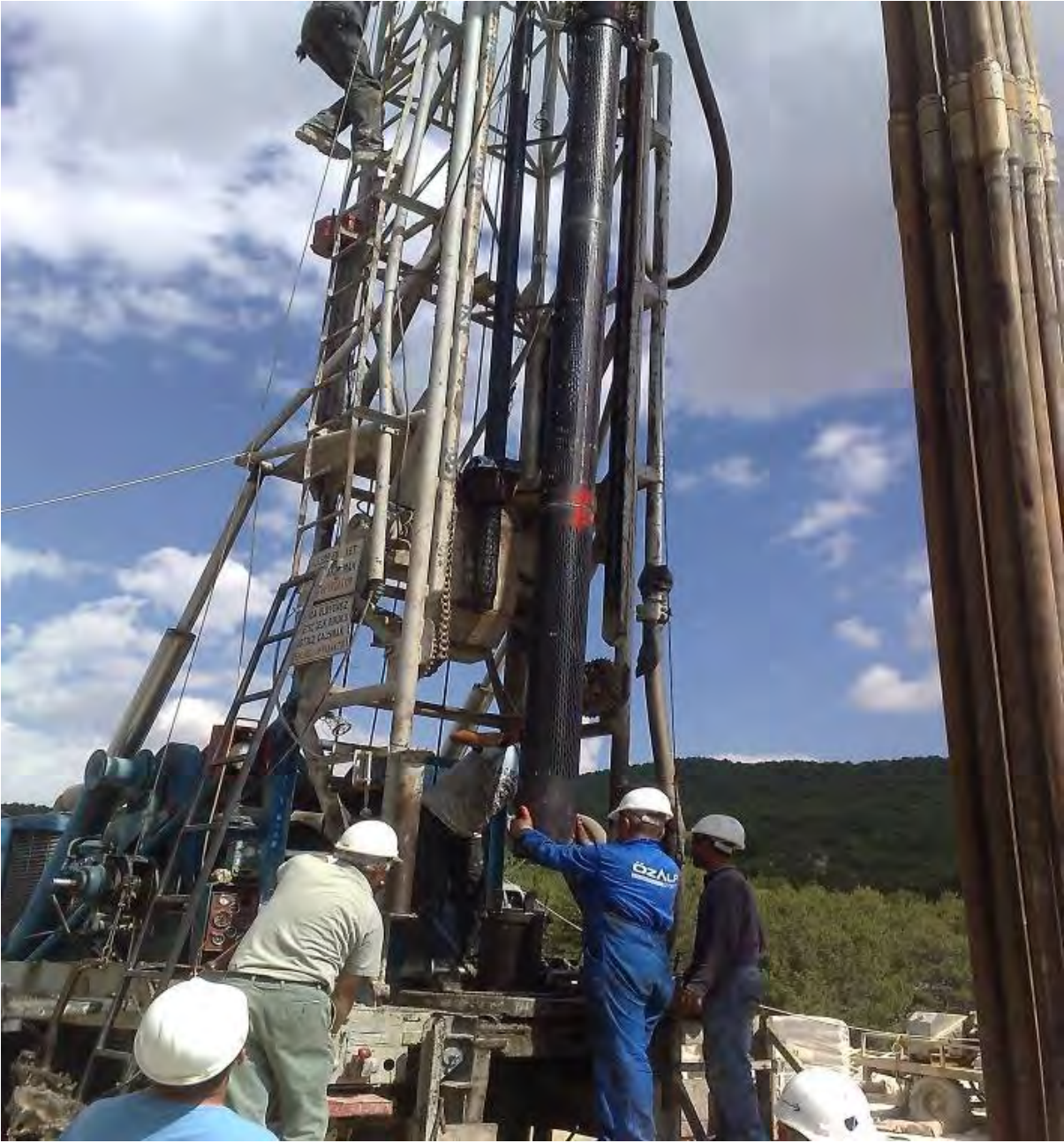
Şekil 5.8. HJP-2 numaralı kuyuda teçhiz işlemi sırasında, 10^{3/4} " çaplı filtreli ve kapalı boruların kuyuya indirilmesi.
