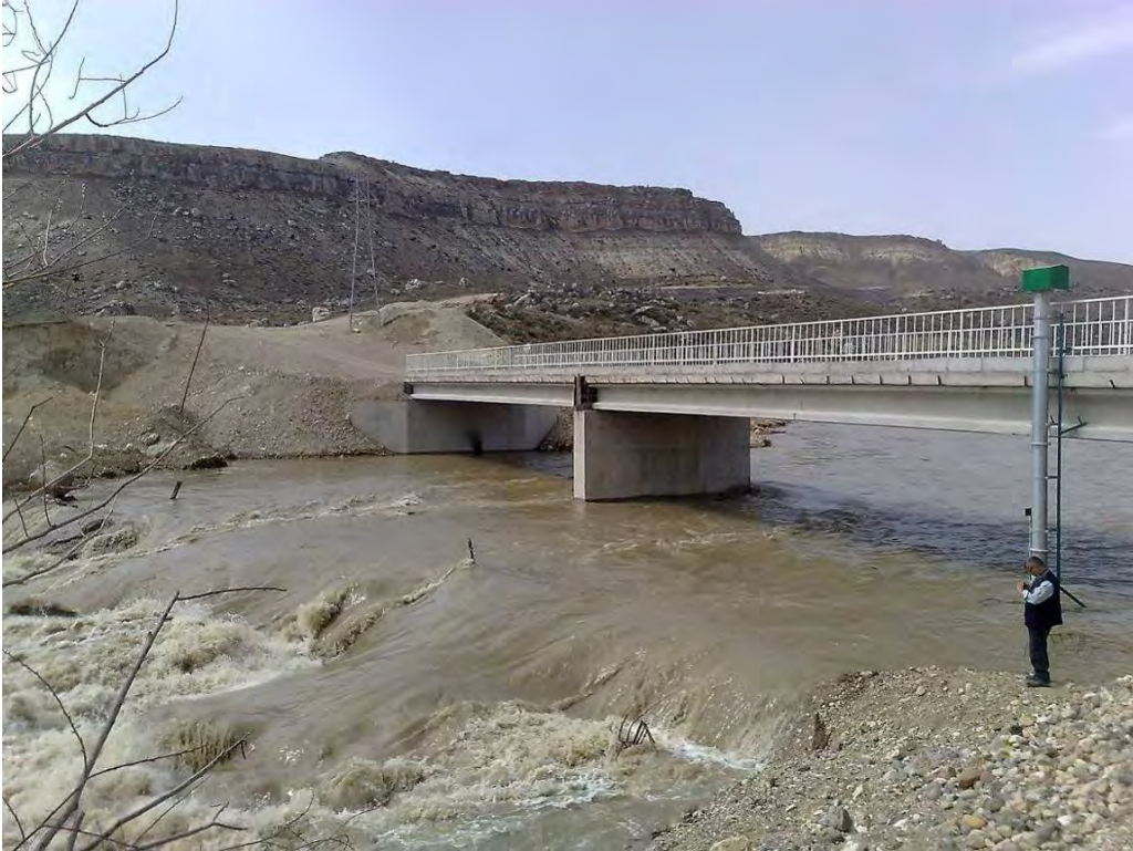
Şekil 5.3. Aladağ Çayı üzerinde kurulan akım gözlem istasyonu.
