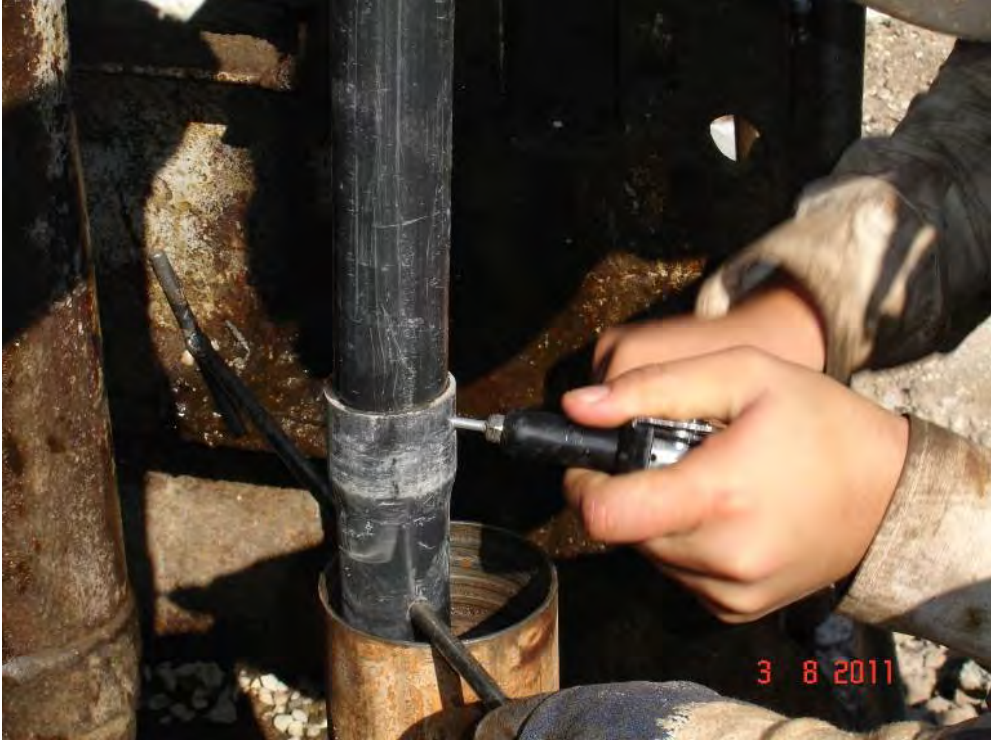
Şekil 5.6. HJB-379 numaralı gözlem kuyusunda plastik boru kullanılarak yapılan teçhiz işlemi
