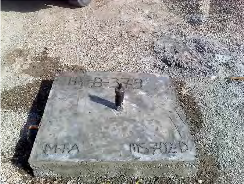
Şekil 5.7. HJB-379 numaralı gözlem kuyusuna ait kuyu başı donanımı
