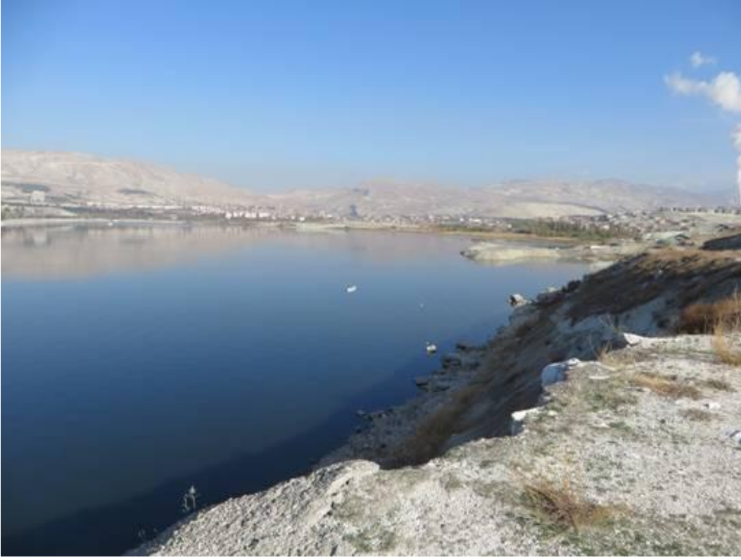
Fotoğraf I.6: Sarıyar Barajı Yaklaşık Su Alma Bölgesi
