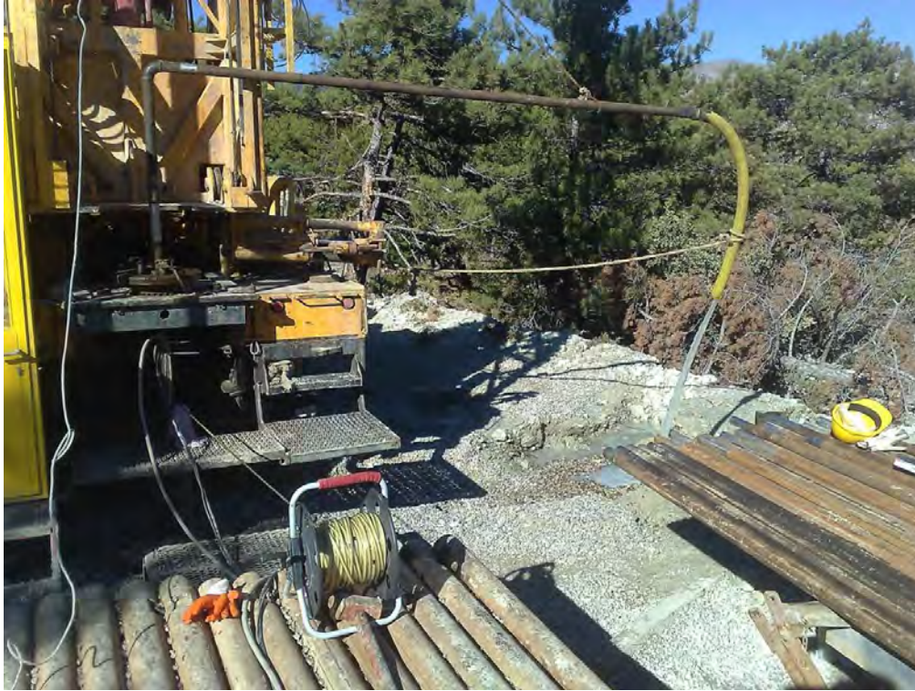
Şekil 5.39. HJP-5 numaralı pompa kuyusunda yapılan pompa testi
