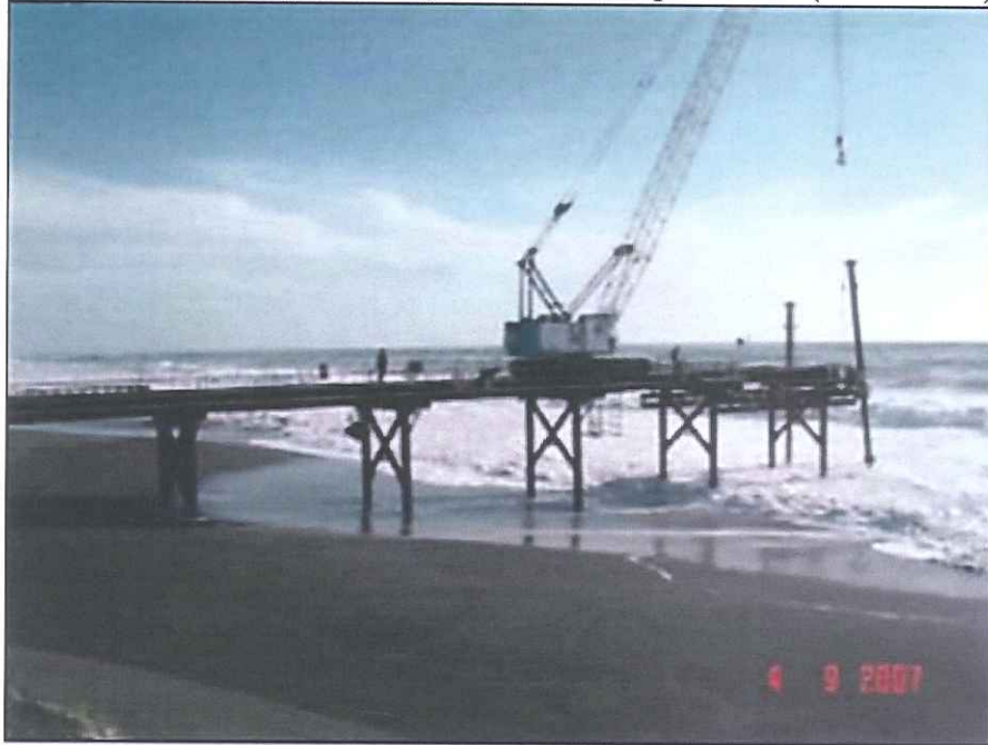
Figura 4-57: Construcción y/o montaje de un muelle provisorio (Referencial)
