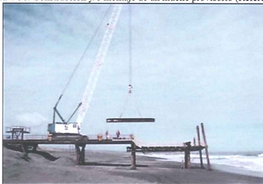
Figura 4-56: Construcción y/o montaje de un muelle provisorio (Referencial)
