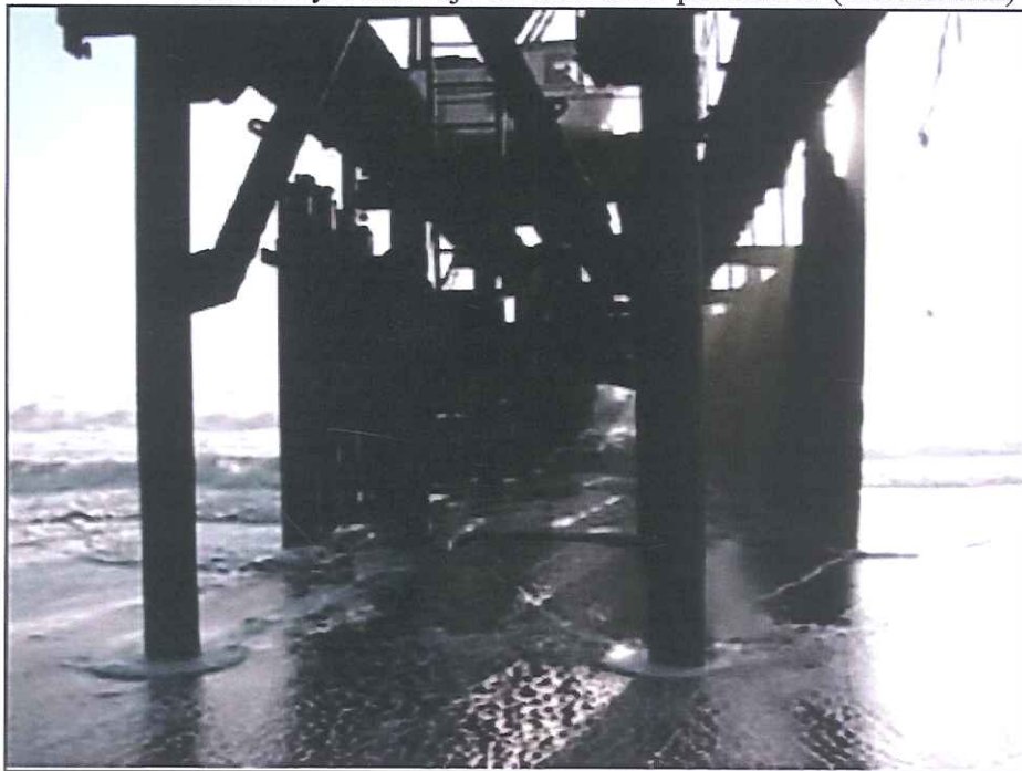
Fotografía 4-58: Construcción y/o montaje de un muelle provisorio (Referencial)
