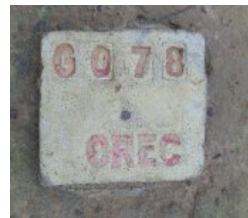
Borne pour l'élargissement de la route
