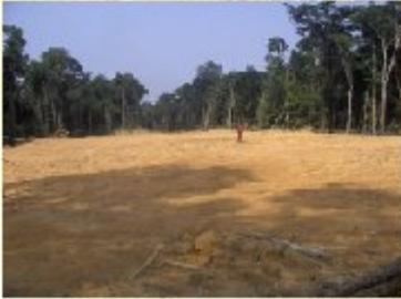
Plate forme créée par la CEMEC à côté du camp FIGET
