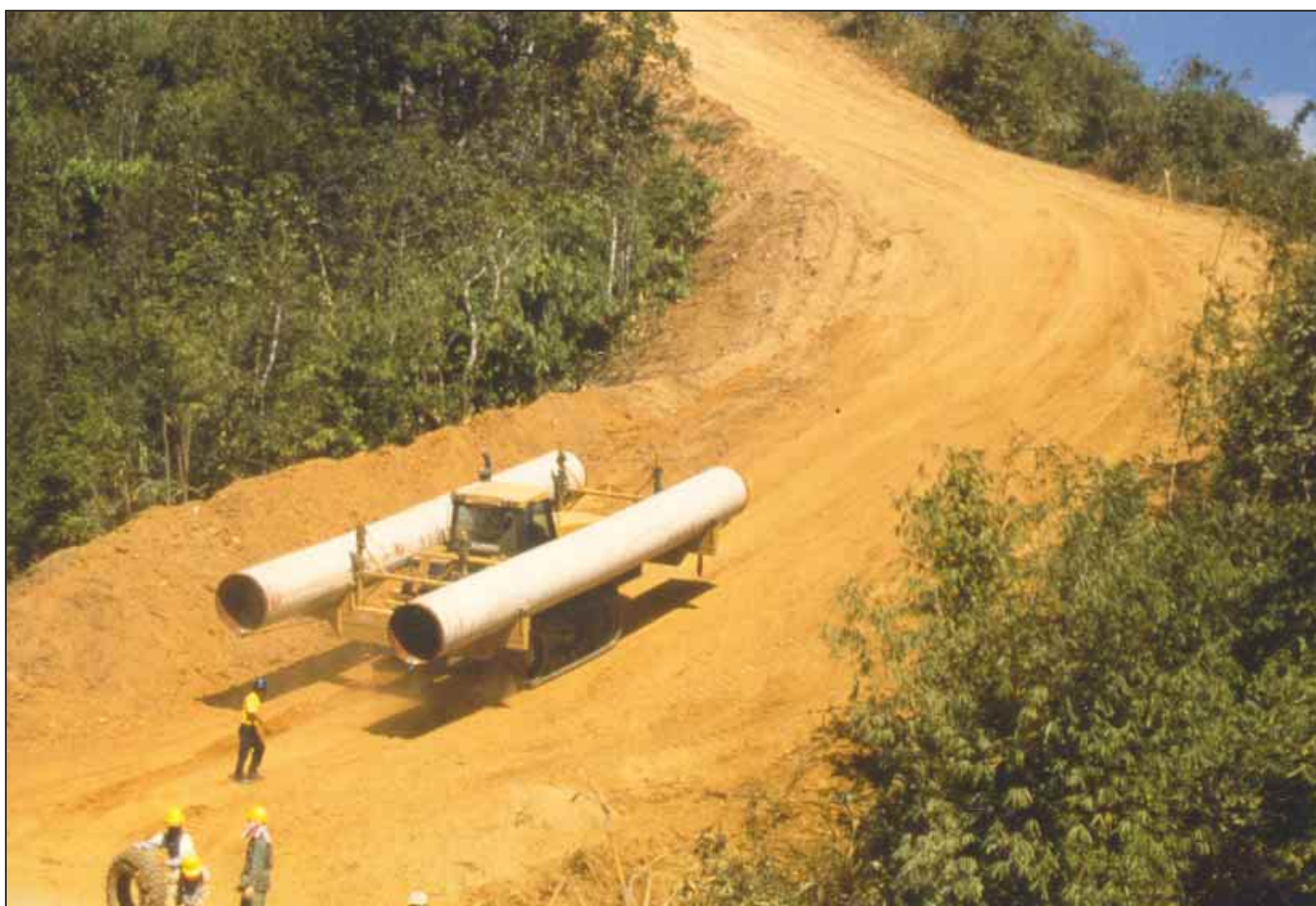
Arbeiders leggen de Yadana gaspijplijn door de Tenasserim regio in Birma.
